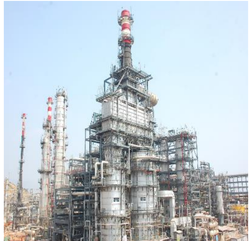
Visakh Refinery - 1.32 MMTPA
